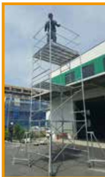
〈ローリングタワー(イントレ)講習〉
